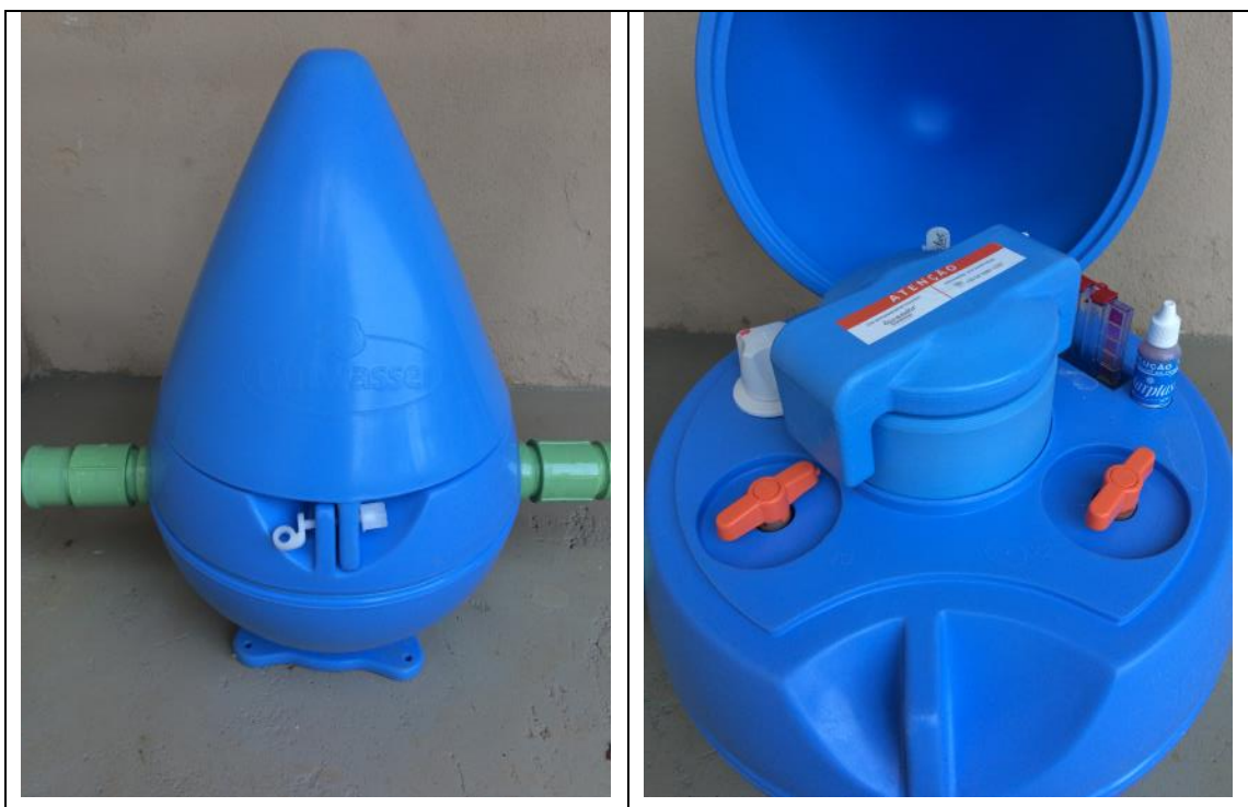
Figura 1: Dosador hidráulico de cloro adotado no condomínio do estudo de caso.
